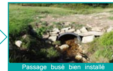
Passage busé bien installé
