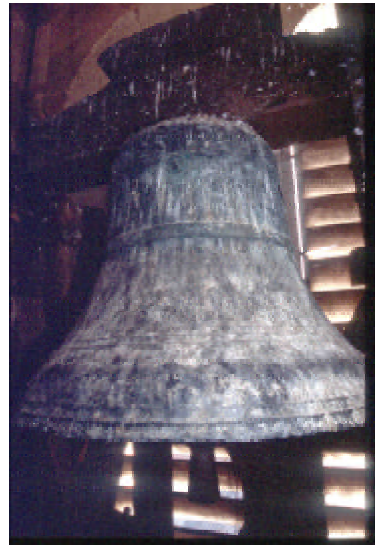
Fig. 2 - Cloche de Bonnay (Saône-et-Loire). On peut distinguer la chasse du battant, beaucoup trop basse par rapport à la normale.
