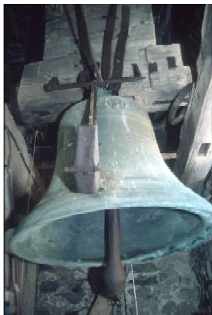
Fig. 4 - Vue de l'installation de Roquefère (Aude) : la cloche est suspendue à son joug qui ne peut être mis en mouvement (axe rompu sur le côté droit).
